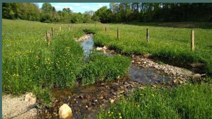
Chantier terminé 6 mois après travaux
