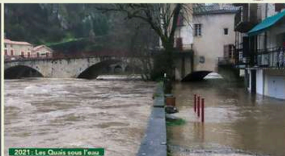
2021 : Les Quais sous l'eau
