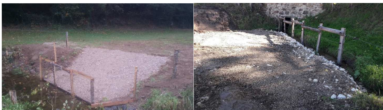
Exemples de descentes aménagées
