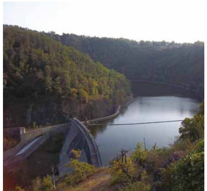
Les barrages (ici celui de Thuriès) sont à l'évidence des obstacles infranchissables pour les poissons.
