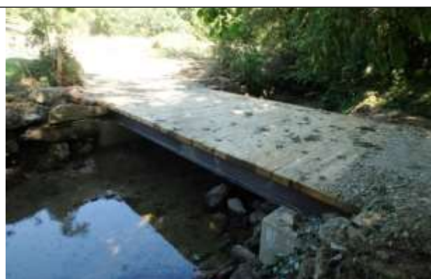
Remplacement d'un gué busé par une passerelle sur le Vayre - Commune de Quins
