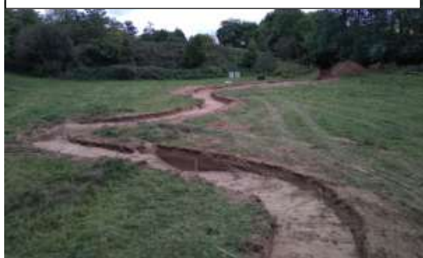
Creusement du nouveau lit selon certains paramètres définis au préalable
